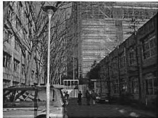
新研究棟工事現場（左：研究棟、右教室棟）
