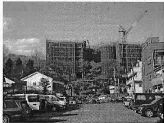
新研究棟工事現場（日吉・記念館側から見る）
